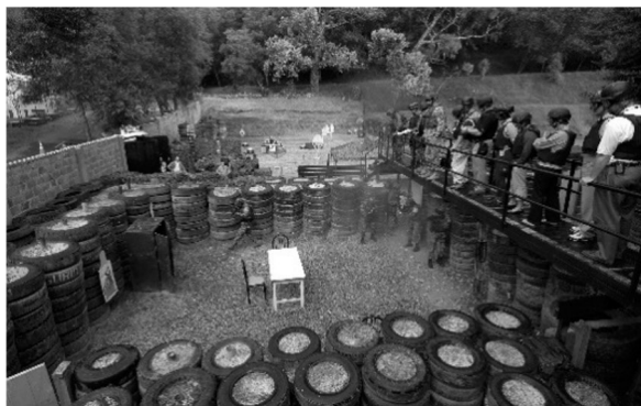
Рис. 1. Примеры построения тактических тренировочных объектов из подручных средств: слева — заполненные землей габионы, справа — заполненные смесью земли и щебенки автомобильные покрышки
